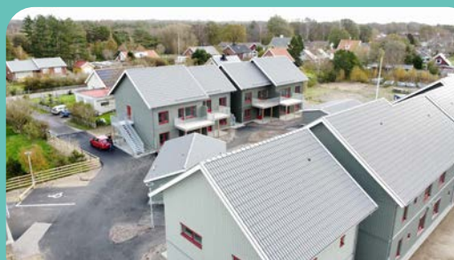
Bild på fastigheten innan planteringen var på plats.
